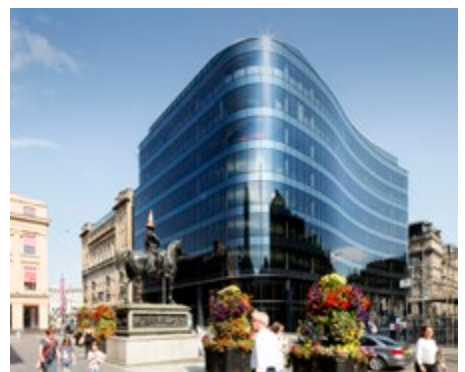
Connect110NS, Glasgow, Großbritannien, Bürogebäude
